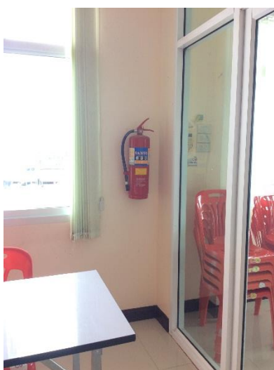
การติดตั้งถังดับเพลิงในอาคารสำนักงาน
